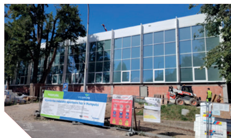
výstavba sportovní haly
