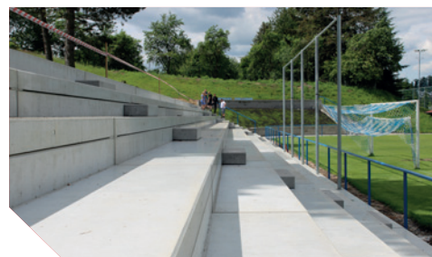
rekonstrukce fotbalových stupňů
