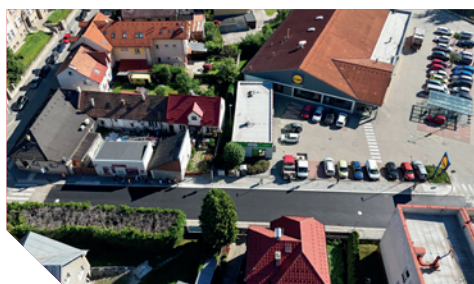
oprava ulice Hálkova
