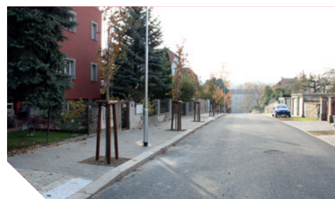
rekonstrukce ulice Mánesova
