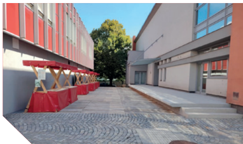
rekonstrukce prostoru vedle kina
