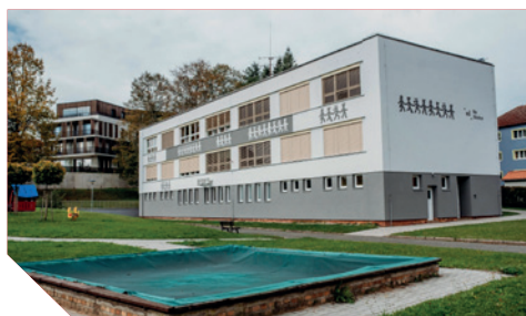
náter fasády MŠ Na Skalce
