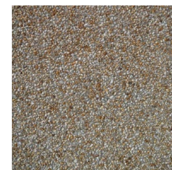
Pochozí plocha pavilonu - vymývaný beton
