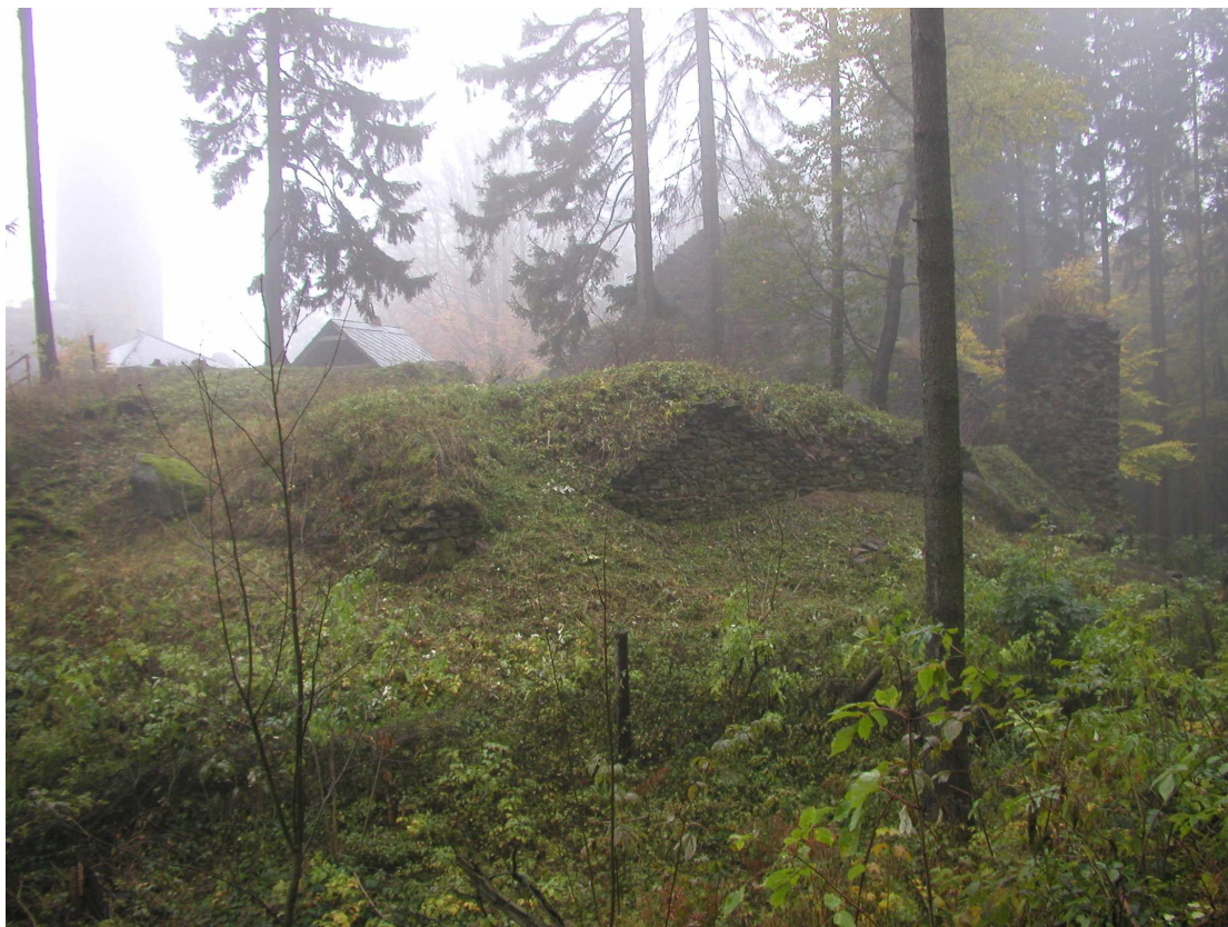
Stav objektu bastionu podzim 2007 – SV nároží se severní zdí
