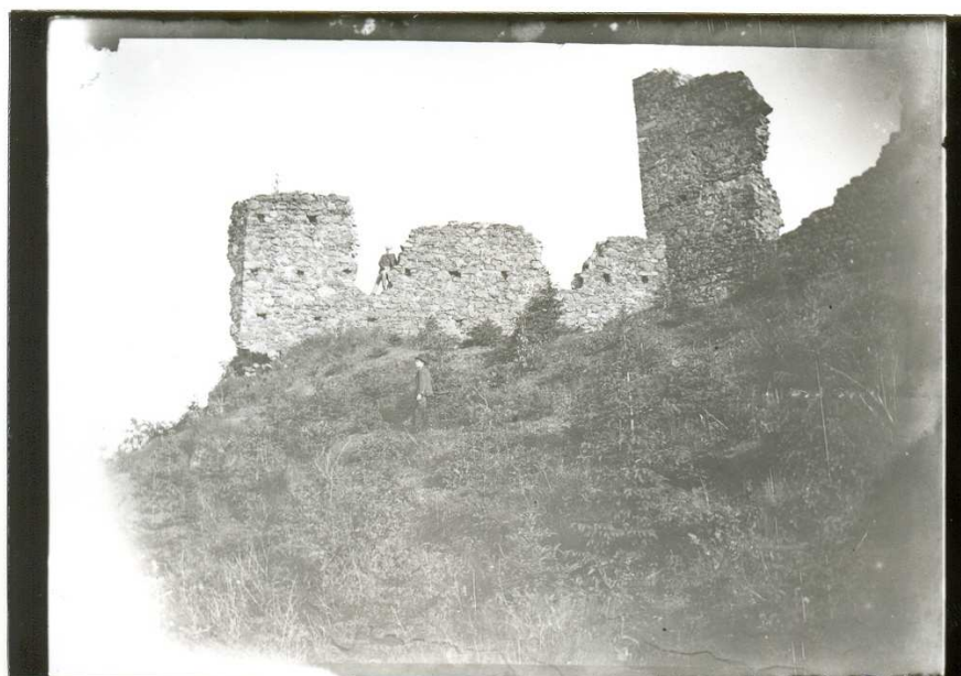
Stav zdiva na počátku 20.století s patrným podlámáním nároží
