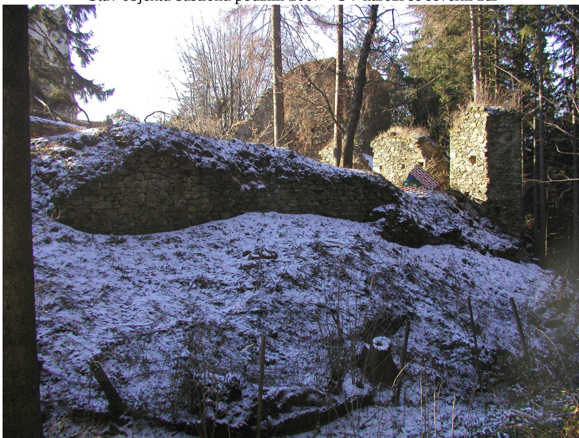
Stav části severní zdi od místa destrukce u SV nároží až k napojení na příčnou zeď západní – prosinec 2007
