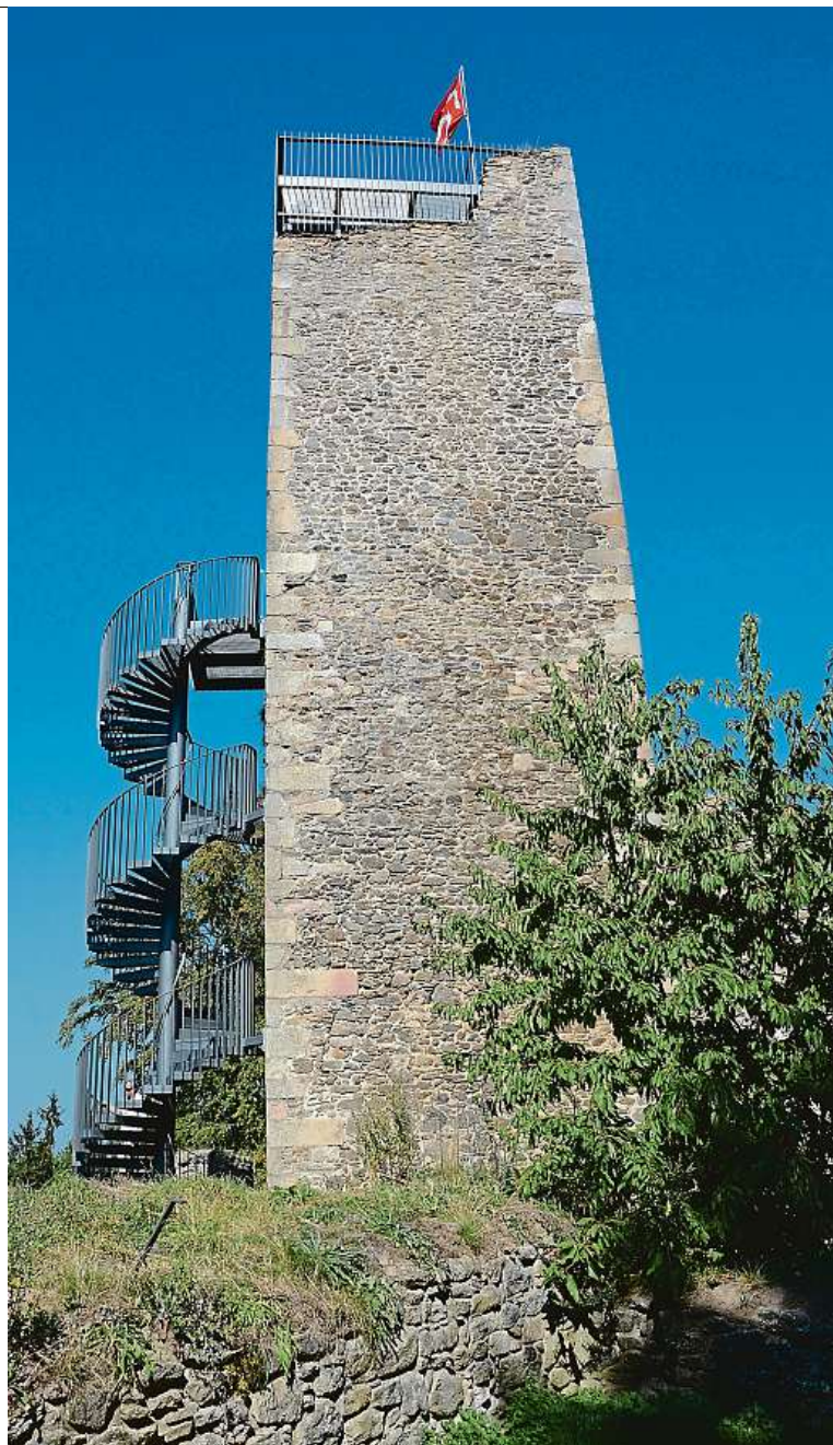
104 schody Nahoru se lidé dostanou po vnějším ocelovém schodišti, navazující konstrukce je pak uvnitř torza věže.
