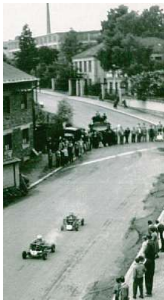
■ Původní závodní trať ve městě – pohled ze střešky pošty do Lnářské ulice
