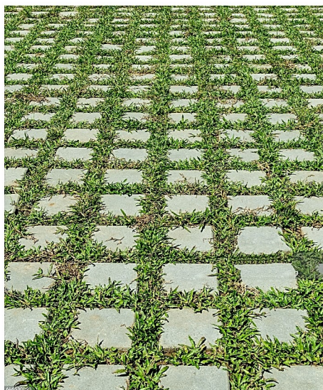
parkovací stání z betonové zatravněvací dlažby
