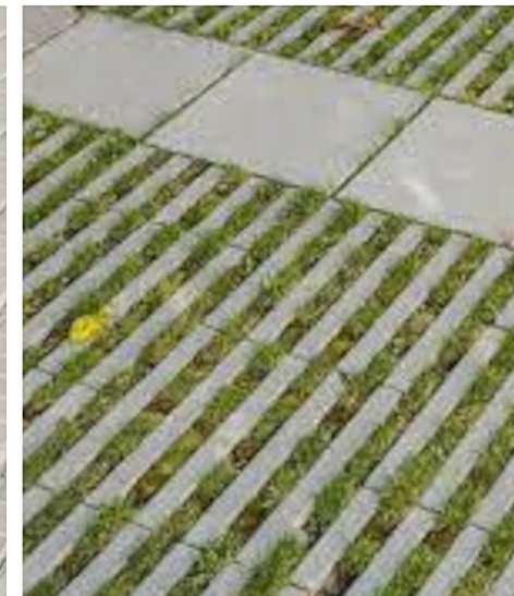
zatravnovací pochozí betonová dlažba 10x10 cm, barva přírodní, povrch hladký, šířka proužků 65 mm
